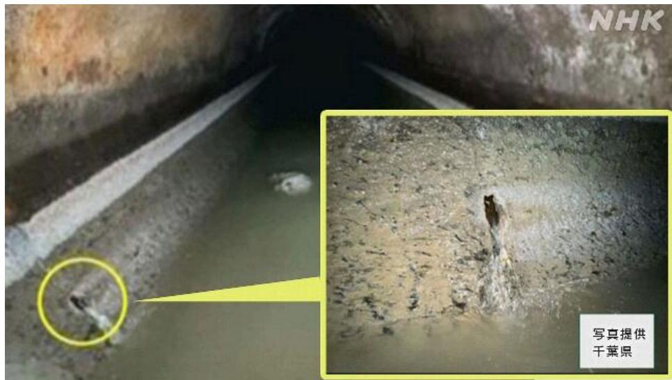
穴の直径はおよそ5センチと、破損の程度は重度の「A」に該当し、穴を通じて外部から管内に地下水が流れ込んでいたということです。
