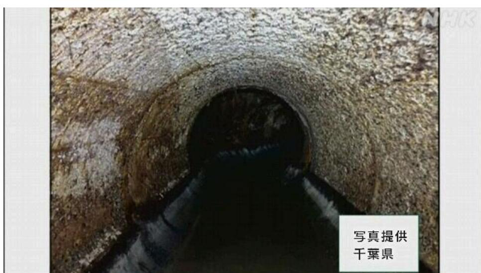
コンクリートが欠損して内部の鉄筋が露出していたため、腐食の程度は重度の「A」に該当します。
